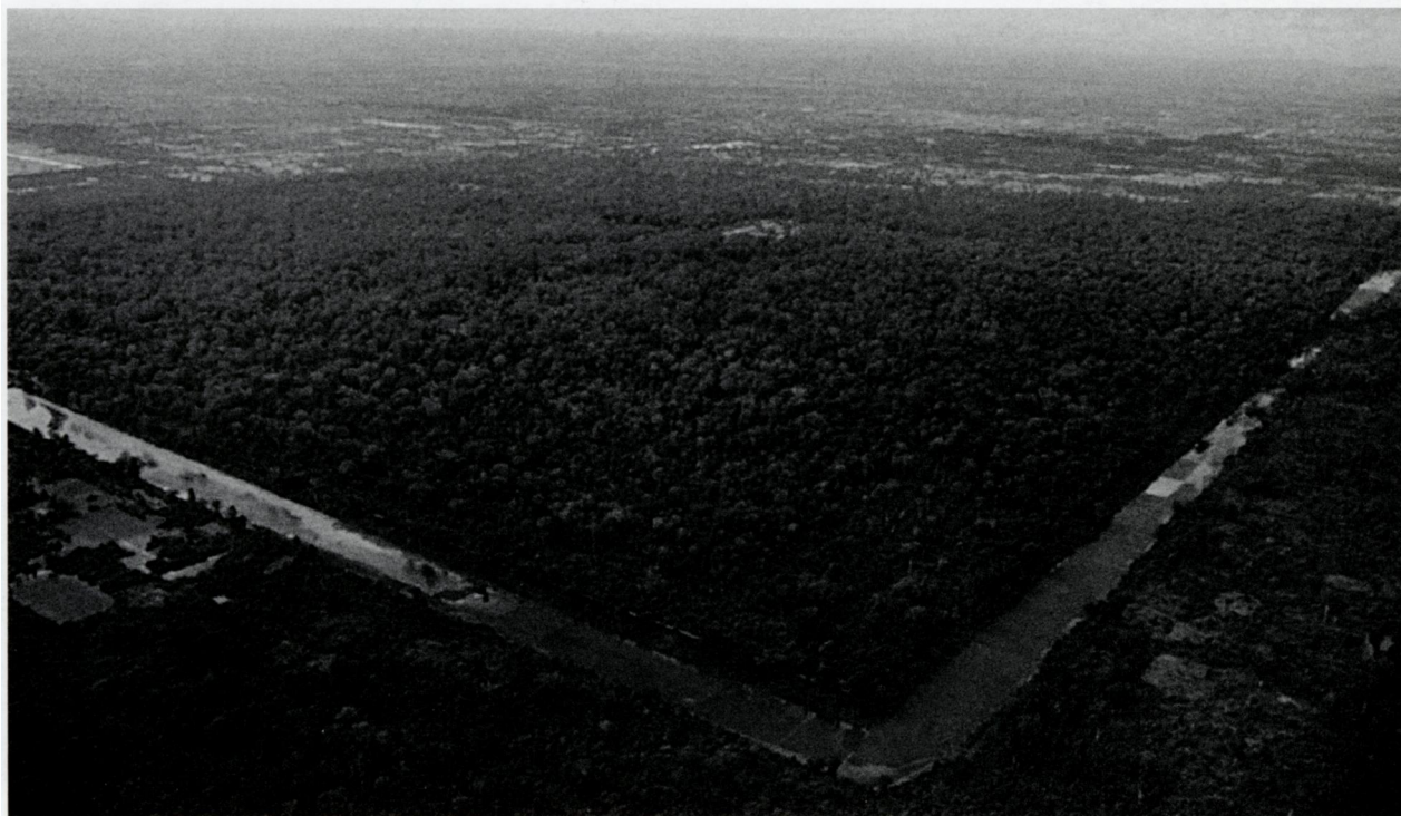
Fig. 8 Angkor Thom, douve extérieure, vue du ciel. Angle sud-est.
