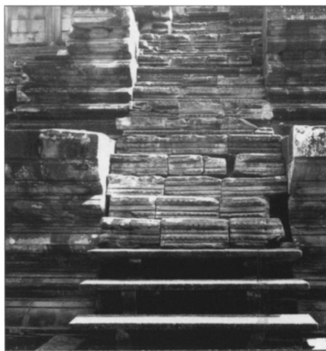
Fig. 12. Escalier Sud après remontage (état actuel).
